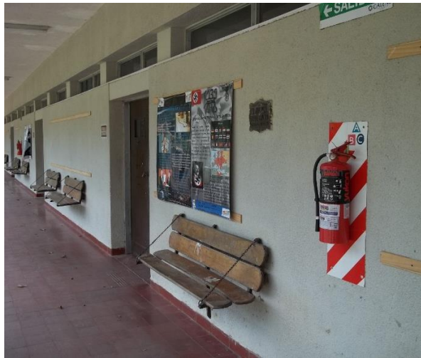
Colocación de extintores y señalética. Técnico en seguridad e higiene.
